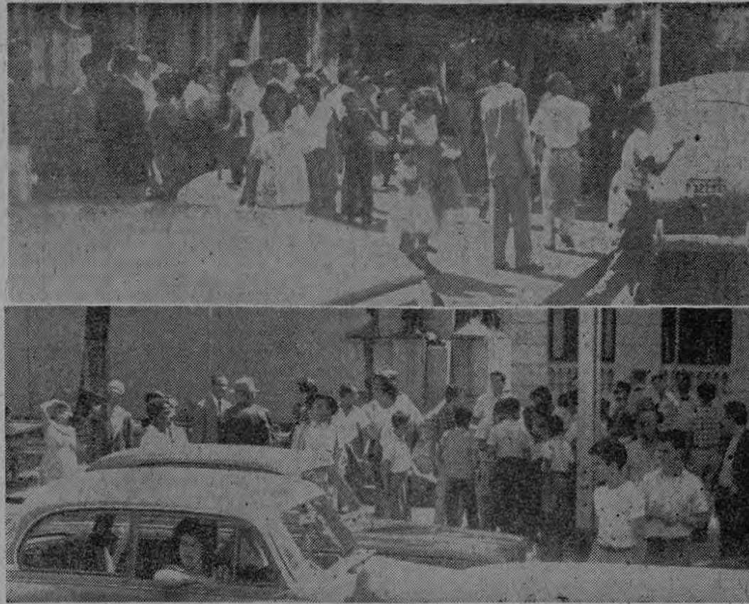
(Arriba). Grupo de ciudadanos alarmados miran hacia las paredes del edificio de Correos y Telégrafos que se agrietó mínimamente en algunos sectores y de cuya techumbre se desprendieron algunas láminas de zinc
